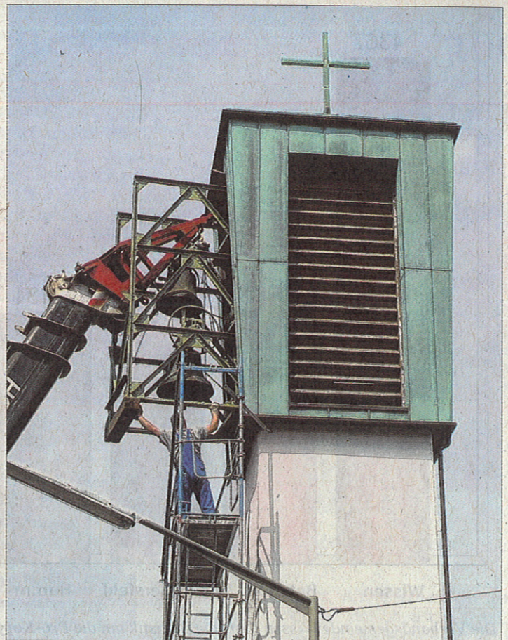
Vor vier Wochen: Ein Autokran macht's möglich. Der alte Glockenstuhl verlässt sein „Zuhause“. Foto: privat
