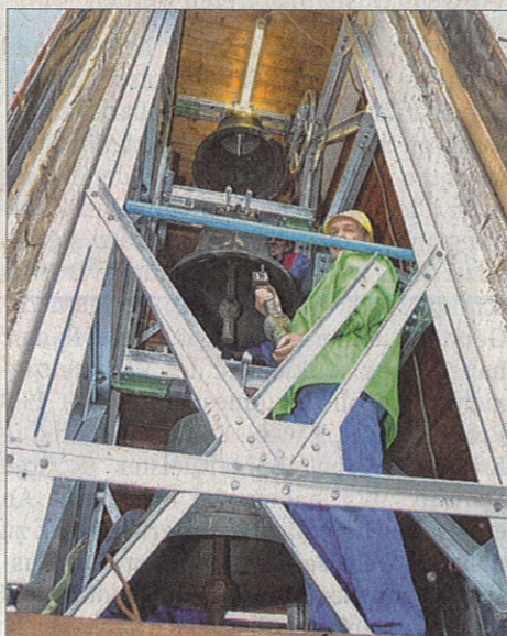
Millimetergenau wurde gestern der Nachbau in den Turm eingepasst. Foto: rai
